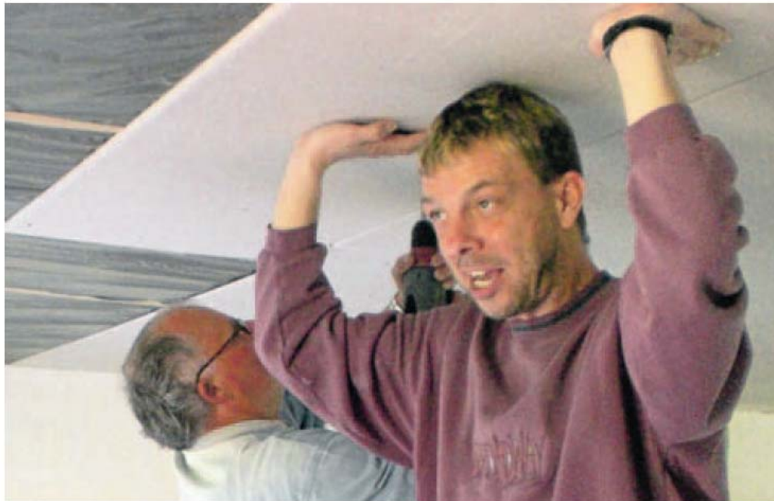
Dank guter Beteiligung der Mitglieder wurde die Sanierung im Meinkoter Schützenheim (hier im Aufenthaltsraum) plangerecht abgeschlossen. Auf dem Bild Torsten Langer (vorn) und Bernd Semrau.
