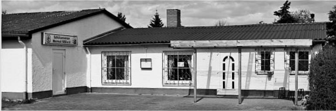
Das Schützenheim in Meinkot: Erst wurde das Dach erneuert – jetzt soll auch Innen renoviert werden. Photowerk (mv)
